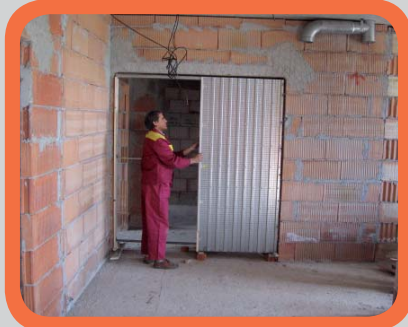
Vložení a usazení stavebního pouzdra do stavebního otvoru dle „vágrysu“
