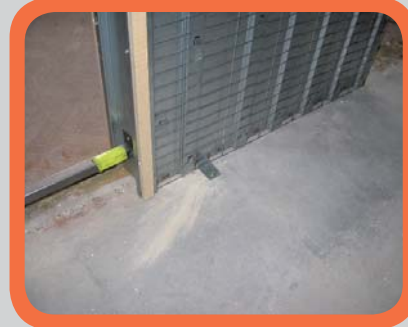
Kotvení pouzdra do podlahy
