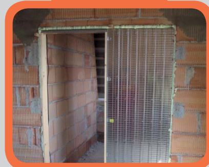
Zapěněné pouzdro ve stavebním otvoru
